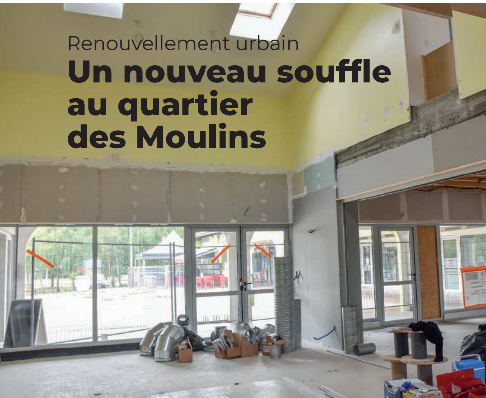
Les travaux vont bon train dans la future Maison des Habitants
