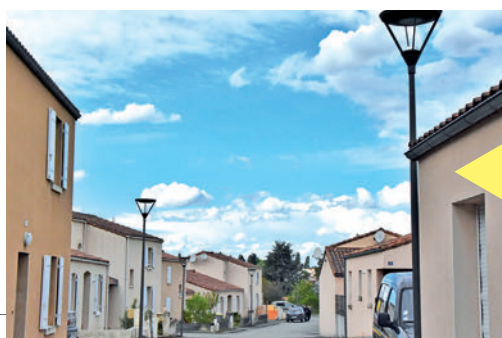
Lotissement Espierre : nouvel éclairage public
